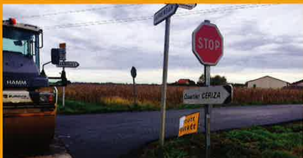
Réfection de la chaussée route de Sarniguet
