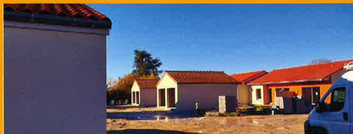
Chantier OPH65 Résidence Senior "Les Palombes": vue partielle du projet
