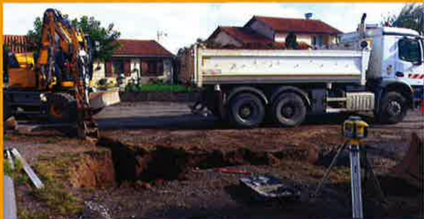
Amélioration et renforcement des équipements d'eau pluviale de la rue Lamayoux
